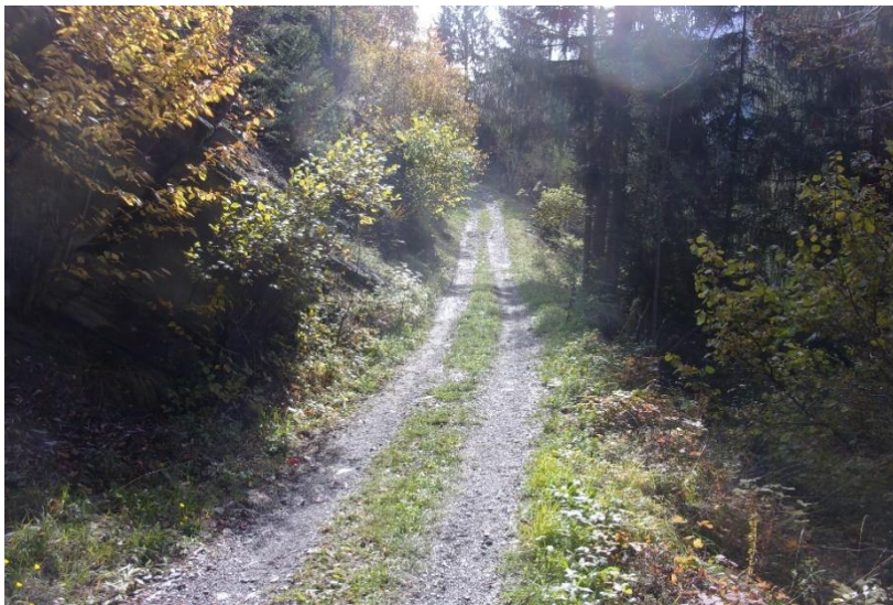
piste forestière à élargir côté aval
