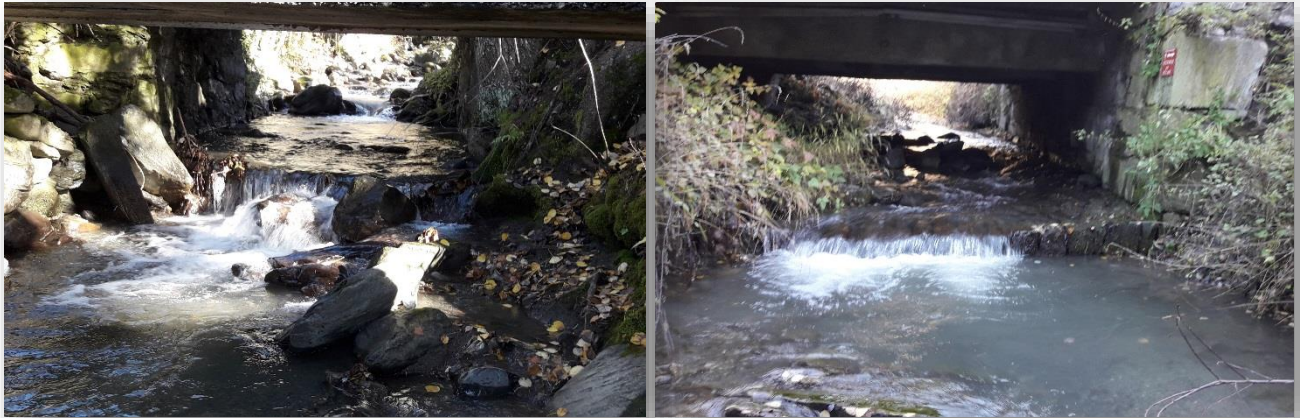
Figure 29 : Obstacles artificiels : au droit de l'ancien pont photo de gauche, au droit du pont de la RD photo de droite.
