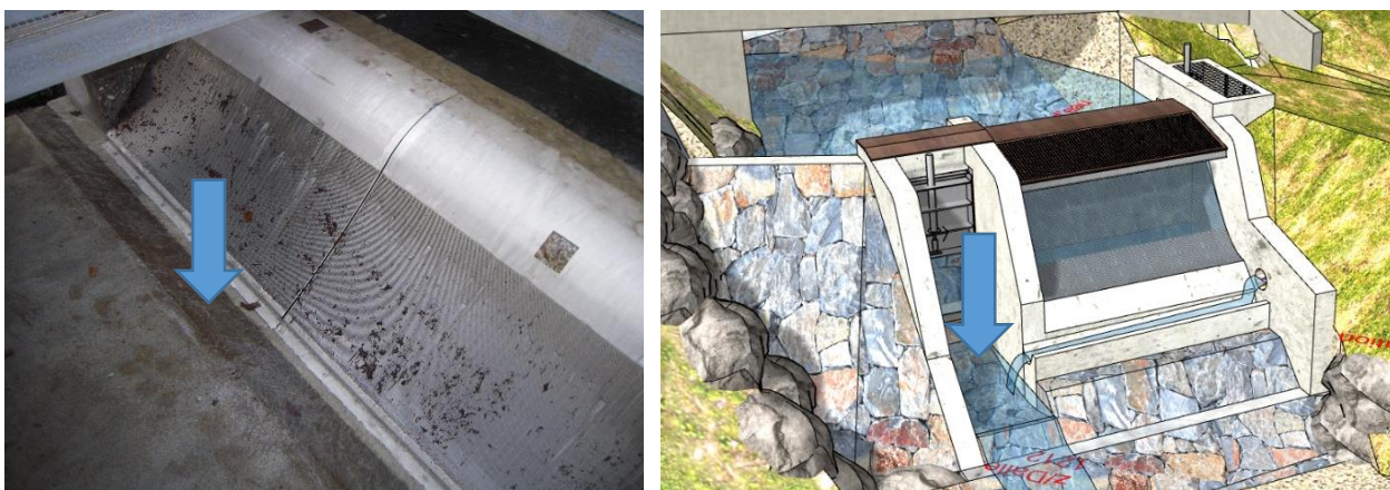
Figure 7 : A gauche goulotte en pied de grille, à droite fosse de réception.
